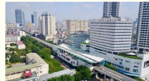
ハノイで建設中のメトロ3号線
