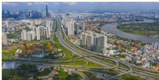
ホーチミンで建設中のメトロ1号線
